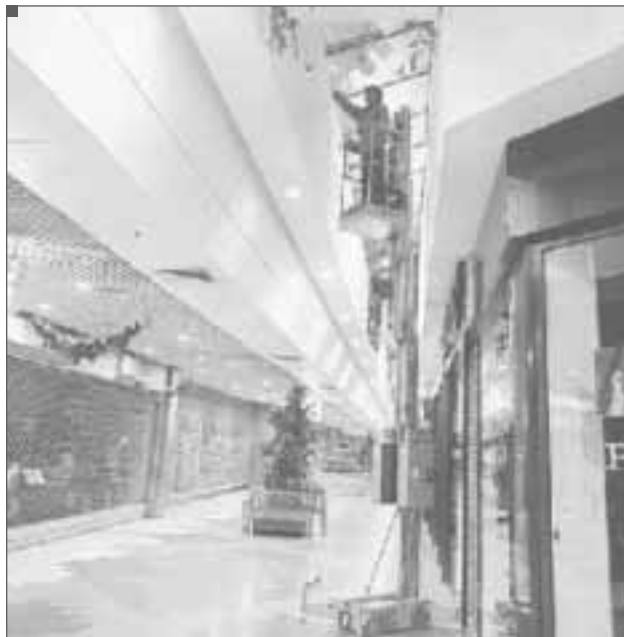
Príklad 4: Čistenie sklenených átrií a striech zvnútra pomocou pojazdnej zdvíhacej pracovnej plošiny (PZPP) s ramenom
